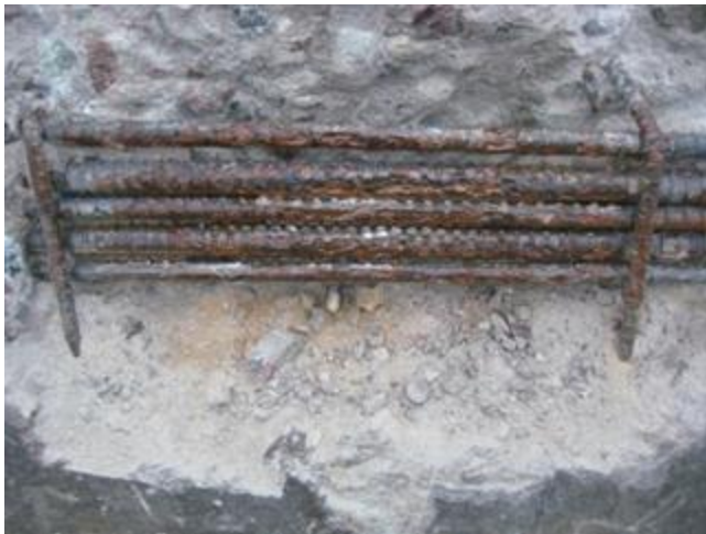
Korrosionsskador på armering i en betongkonstruktion
